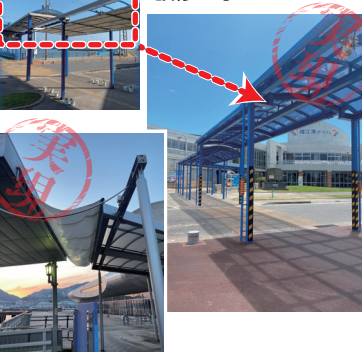
長崎港の栈橋通路屋根工事
