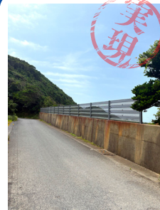
富江黒瀬付近 防風ネット設置
