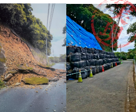
一般県道奈留線の法面崩壊補修工事
