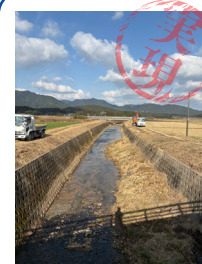
郷津川河川浚渫工事
