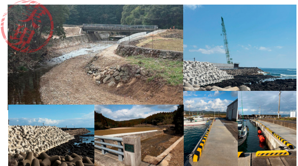
富江町倭寇漁港・山下漁港・中須河川の竣工工事
