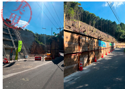
五島市圏内の各工事着工
